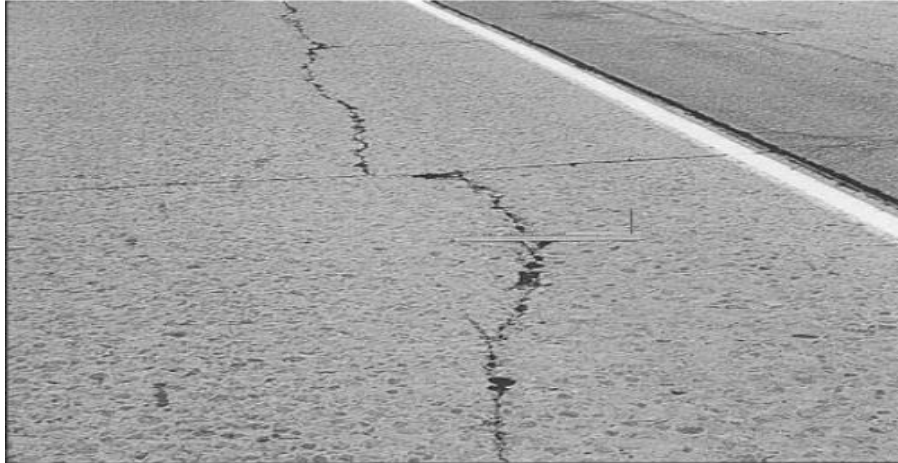
Foto N°1: Grieta Longitudinal
