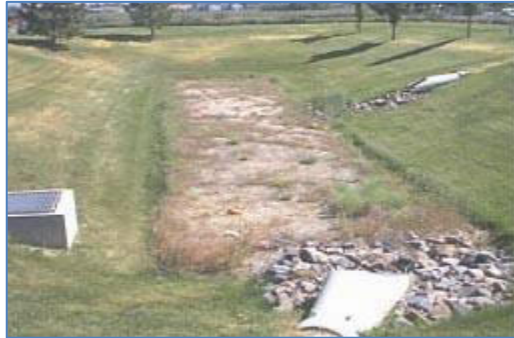
Figura 5.5-4 Estanque de infiltración
