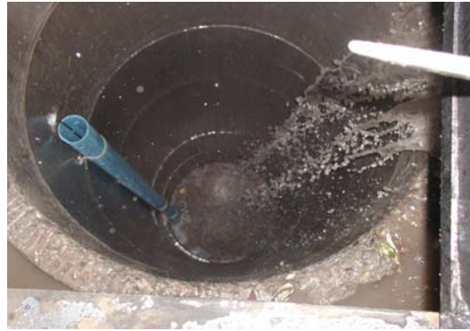
Figura 12: Pozo de infiltración semiprofundo.
