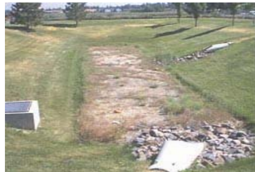
Figura 10: Estanque de infiltración.
