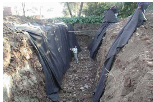
Figura 11: Zanja de infiltración en construcción.
