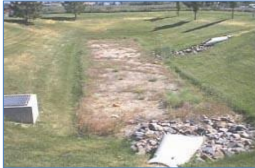
Figura 5.5-4 Estanque de infiltración
