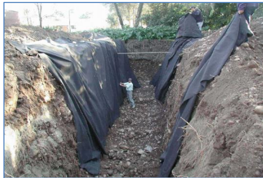
Figura 5.5-5 Zanja de infiltración en construcción
