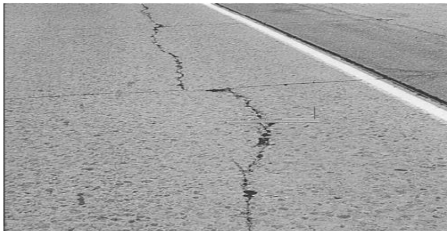
Foto N°1: Grieta Longitudinal
